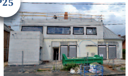
Travaux La maison médicale
