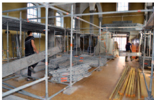
50 tonnes d'échafaudages ont été entreposées en attendant d'être montées.
